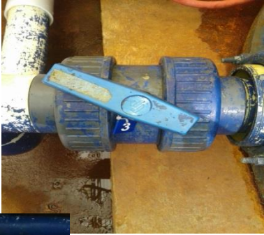
Ilustración 18. Válvula salida Flomax V3-NA
