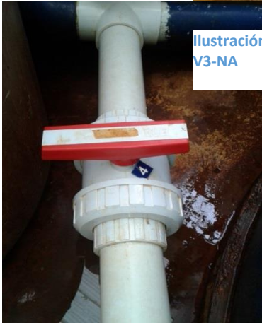
Ilustración 20. Válvula Bypass Flomax V4-NC
