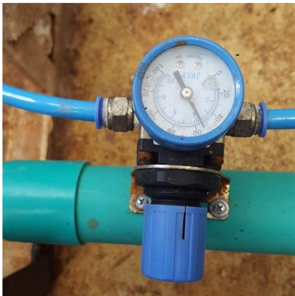
Ilustración 15. Válvula reguladora de presión
