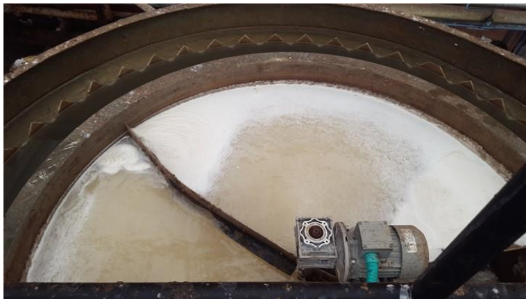
Ilustración 25. Formación de microburbujas en superficie tanque DAF
