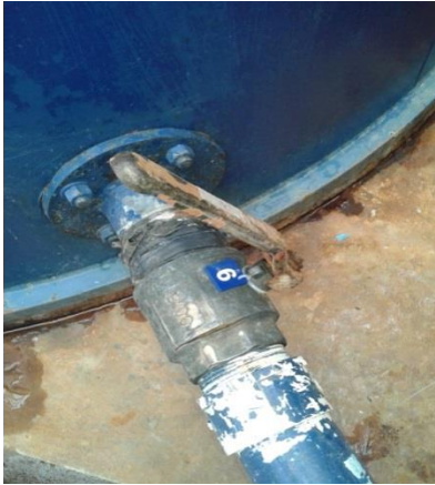
Ilustración 21. Válvula de lodos Flomax V6-NC
