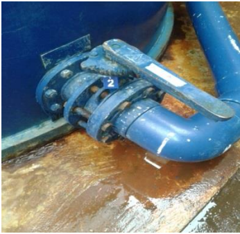
Ilustración 19. Válvula entrada Flomax V2-NA
