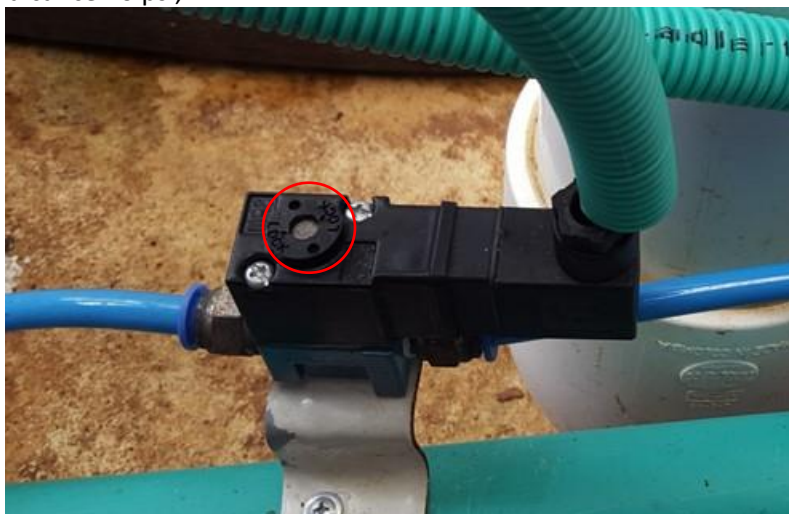
Ilustración 16. Válvula solenoide (rojo).
